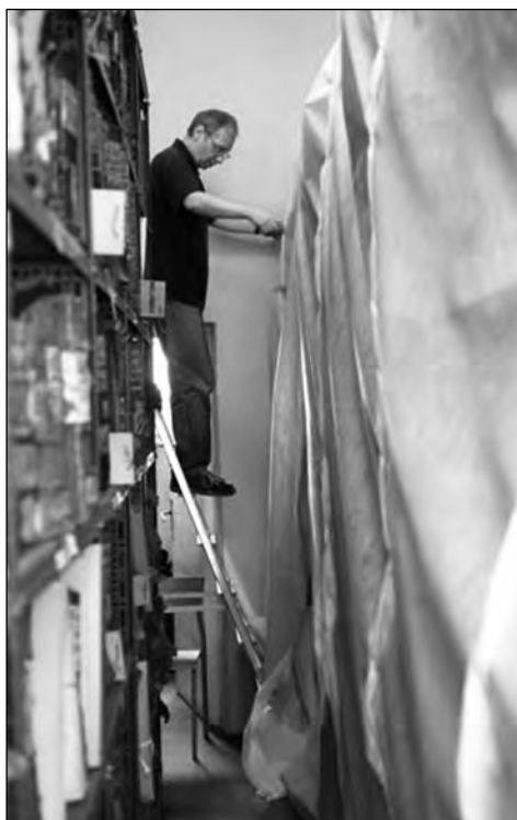
52. Przygotowania do remontu. Rafał Jankowski owija regały włókniną chroniącą przed zanieczyszczeniami (2011 r.) / Preparing for renovation. Rafał Jankowski wraps shelves in nonwoven fabric to protect them against pollution (2011)
