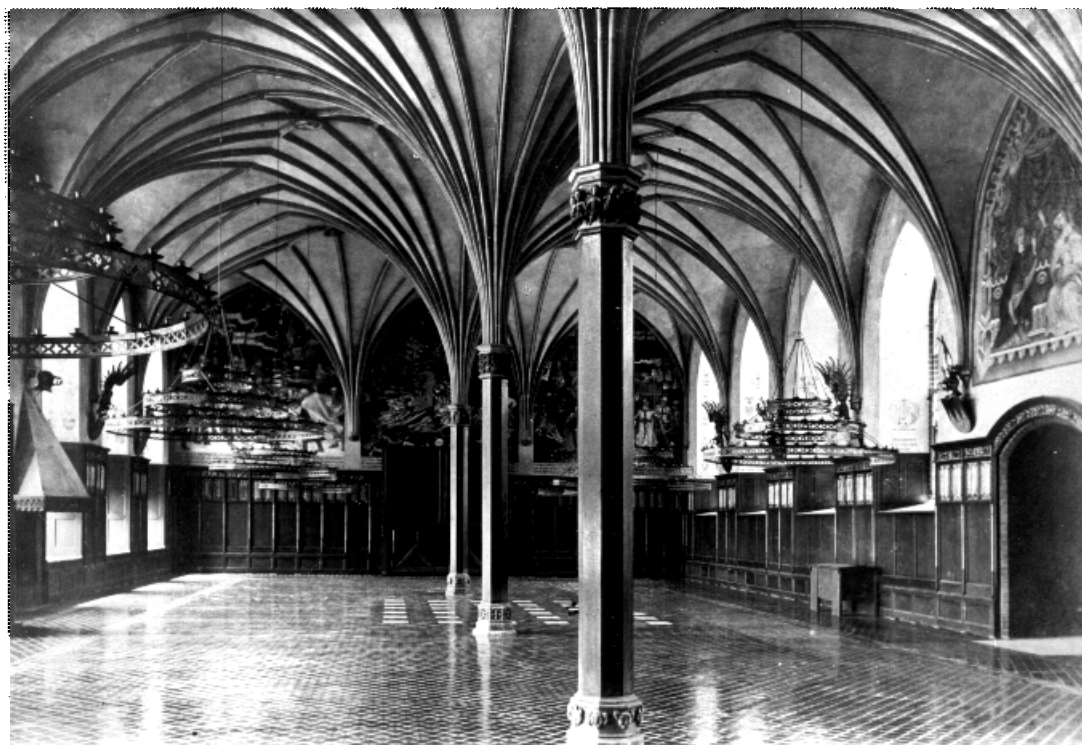
1. Widok ogólny Refektarza. Stan sprzed 1915 r.
