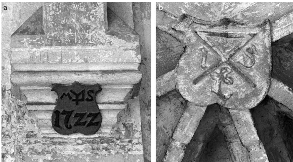
14. Znaki kamieniarzy budowniczych wraz z inicjałami na tarczach: a) mistrza MS pod emporą muzyczną w kościele św. Piotra i św. Pawła w Strzegomiu, 1522, b) Lucasa Schleierwebera (?) na zworniku kaplicy św. Antoniego w Strzegomiu, ok. 1525–1535
